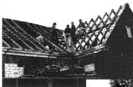
Sanierung des Dachstuhls durch die Mitglieder der Bruderschaft
