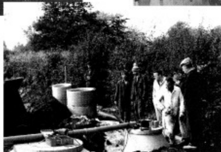
Ein Dreikammersystem mit anschließender Verrieselung wurde im ehemaligen Schulgarten angelegt.
